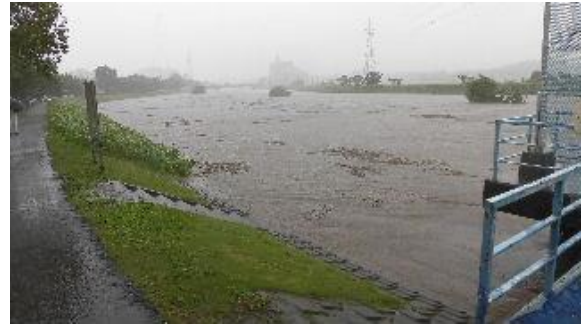
刻々と増水してくる
