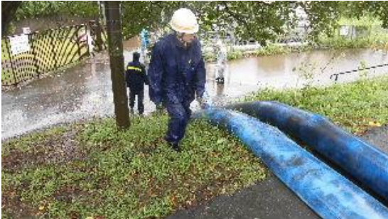
町内会有志もポンプに呼び水作業をする
