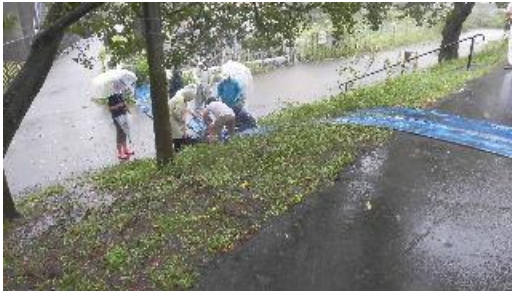
ボルトを繋ぐ作業
