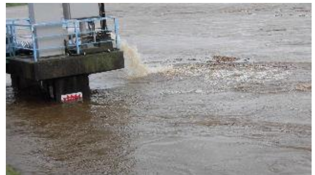
2 台目稼働 (2 時間半掛かった)
