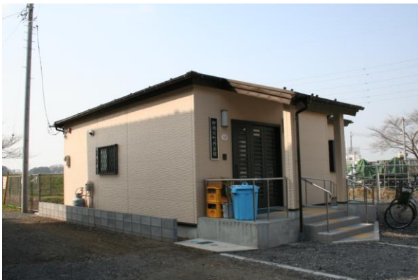
フェンスを造る前
