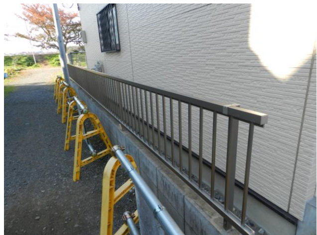
フェンス完成
