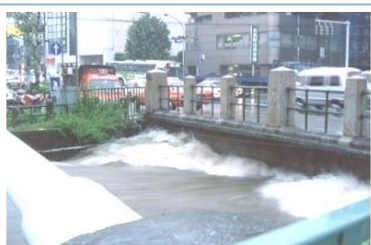
(平成3年台風18号) 台風による大雨で住家全壊1棟、床上浸水6,382棟、床下浸水22,059棟等の被害が発生し、与野市、草加市、志木市、朝霞市及び富士見市の5市に災害救助法が適用された。
